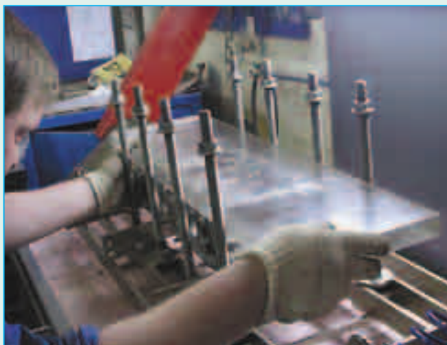
На прокладки устанавливается прозрачная плита, изготовленная из оргстекла. Она позволит осматривать поверхность головки при испытаниях.
